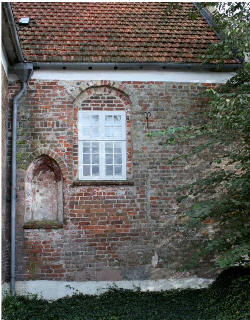
Fig. 16. Udsnit af korets sydмур med oprindelige, nu blændede \dagger vinduer, jf. fig. 12 (s. 1038) og eftermiddelalderligt vindue (s. 1049). Foto Hugo Johannsen 2008. – Ausschnitt aus der Südmauer des Chores mit ursprünglichen, jetzt verblendeten \dagger Fenstern und nachmittelalterlichem Fenster.
