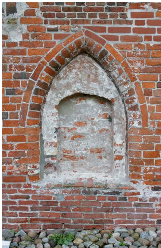
Fig. 14. Langhusets blændede norddør (s. 1035). Foto Hugo Johannsen 2008. – Verblendete (†) Tür an der Nordwand.
