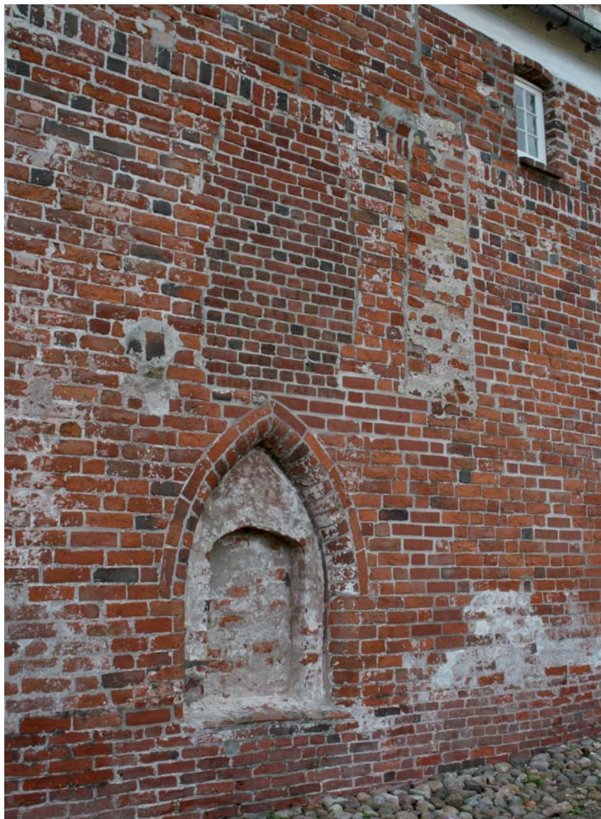
Fig. 17a. Udsnit af langhusets nordmur med oprindelig (†)dør (s. 1035) og spor af †overdøre til †herskabspulpitur (s. 1072) og †nonnepulpitur (s. 1042), jf. fig. 17b. Foto Hugo Johannsen 2008 – Ausschnitt der Nordmauer des Langhauses mit ursprünglicher (†)Tür. Oben rechts Eingang zur †Nonnenempore, oben links zur †Herrschaftsempore, vgl. Abb. 17b.
