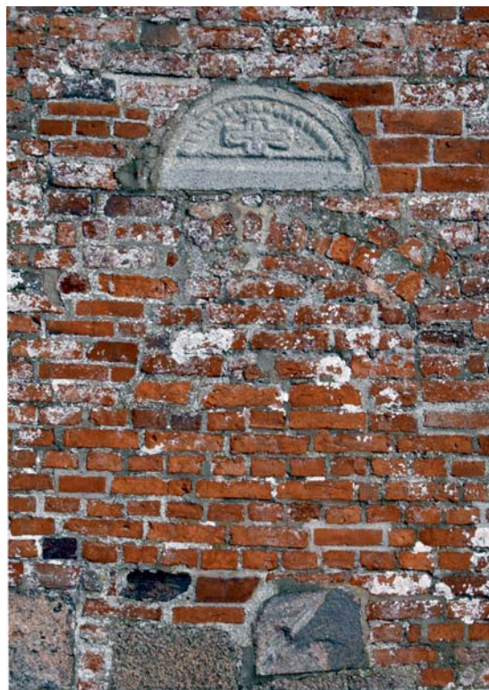
Fig. 7. Blændet †dør på langhusets sydside (s. 1036) med romansk tympanon af granit (s. 1033). Foto Hugo Johannsen 2008. – Verblendete †Tür an der Südseite des Langhauses mit romanischem Tympanon aus Granit.
