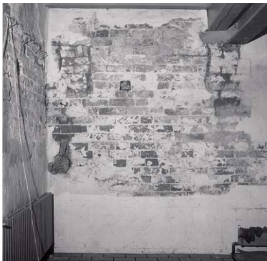
Fig. 21. Udmurede bjælkehuller til †nonnepulpitur i nordsiden af langhusets 5. fag (s. 1043). Foto Morten Aaman Sørensen 1966. – Balkenlöcher für †Nonnenempore im fünften Joch der Nordseite des Langhauses.
