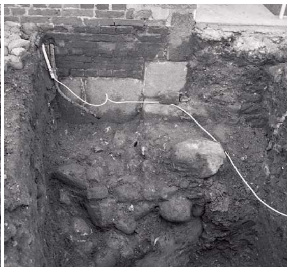
Fig. 19-20. 19. Fundament til \ddagger støttepille ved langhusets nordside mellem 1. og 2. fag, jf. fig. 18 (s. 1047). 20. Fundamentrester ud for langhusets nordvestre hjørne, jf. fig. 18 (s. 1031). Foto Henrik Græbe 1981. – 19. Fundament für \ddagger Stützpfiler an der Nordseite des Langhauses zwischen erstem und zweitem Joch. 20. Fundamentreste an der nordwestlichen Ecke des Langhauses.
